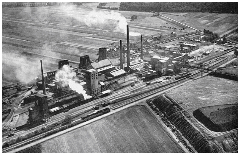
Abb. 2: Luftaufnahme des Georgschachtes etwa 1930 (Quelle: KRUMSIEK 1981)
