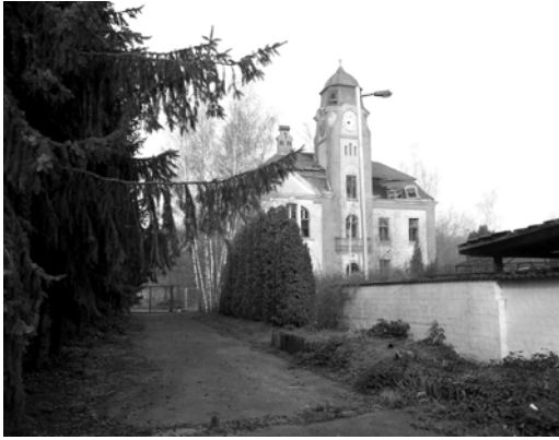
Abb. 8: Das ehemalige Zechenhaus der Schachanlage Georgschacht, im Verfall begriffen (Eigene Aufnahme)
