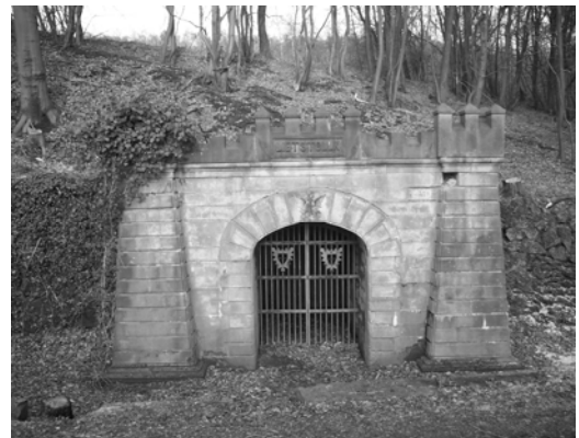
Abb. 13: Das Stollenportal des Liethstolln (Eigene Aufnahme)
