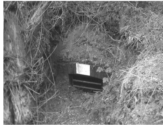
Abb. 11: Stollenmundloch im Wald bei Liekwegen; heute Fledermausquartier (Eigene Aufnahme)
